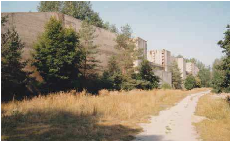
Rohbau des unvollendeten Schiffshebwerks Hohenwarthe, Oberhaupt und Flügelmauern wurden nach 1990 abgebrochen
