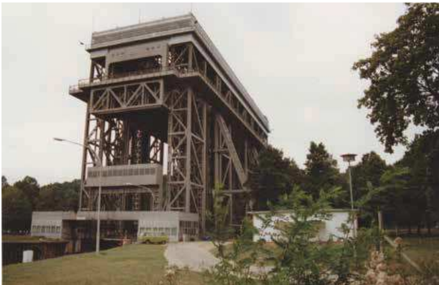
Schiffshebwerk Niederfinow Blickrichtung Westen
