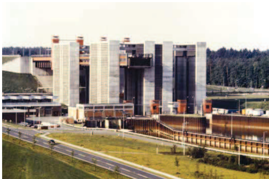
Schiffshebewerk Scharnebeck, Blick vom Unteren Vorhafen (Aufnahme März 1993)
