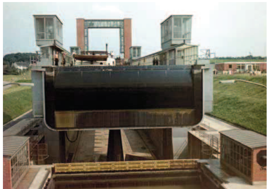
Neues Schiffshebewerk Henrichenburg beim Absenken des Troges (Aufnahme Juli 1963)
